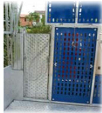
**STRUCTURE RENFORCÉE :** LA CABINE EST EN ACIER GALVANISÉ. LES PORTES BASCULANTES SONT ÉGALEMENT CONÇUES EN ACIER GALVANISÉ À CHAUD.
